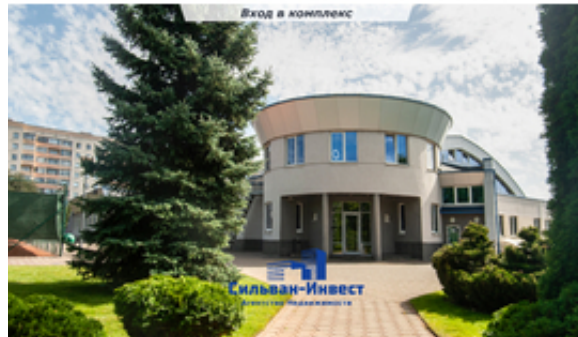
Вход в комплекс
