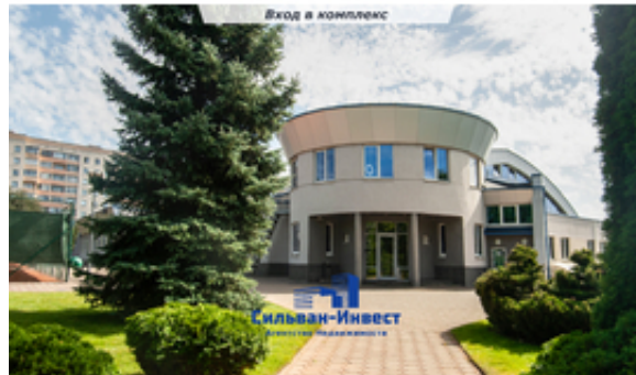
Вход в комплекс
